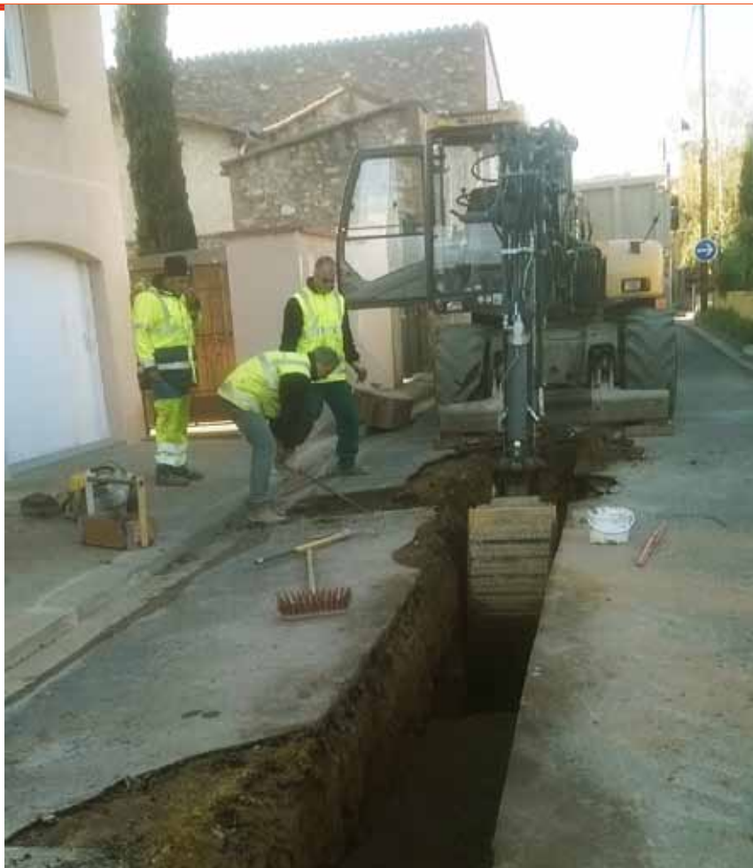
Travaux au niveau des égouts dans la rue de la Tranquillité
