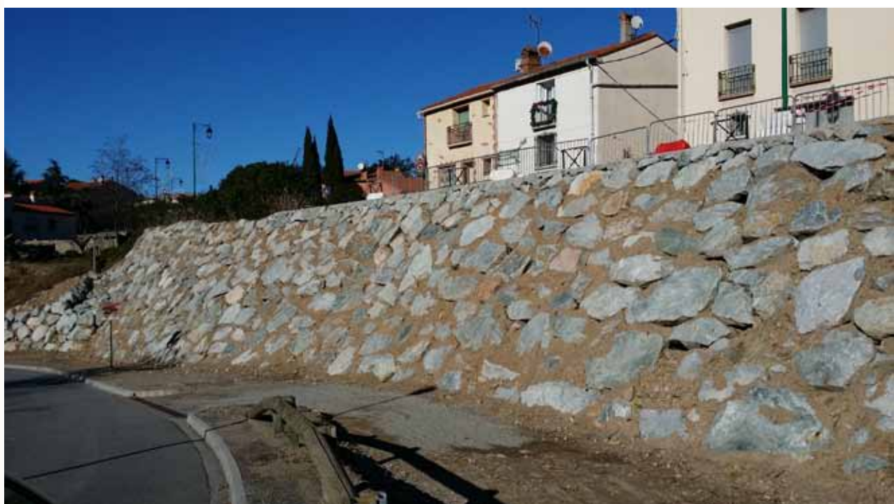
Réalisation d'un enrochement pour renforcer la D13 traversant le village
