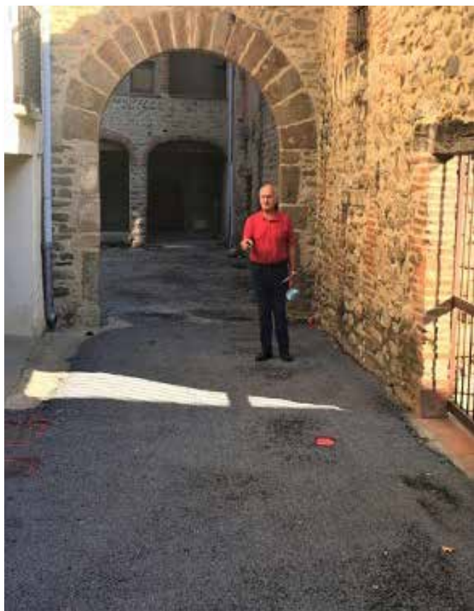
Michel Androdias 1er adjoint en charge de l'urbanisme vérifie le revêtement provisoire rue du Château
