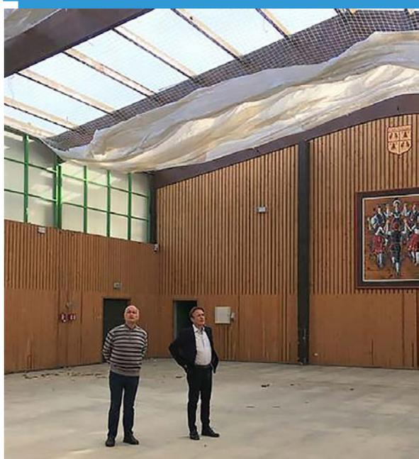
La rénovation thermique de la salle polyvalente est en bonne marche : elle consiste à améliorer l'isolation thermique des parois verticales de la toiture, et à remplacer l'ancien chauffage par un système thermodynamique réversible.
