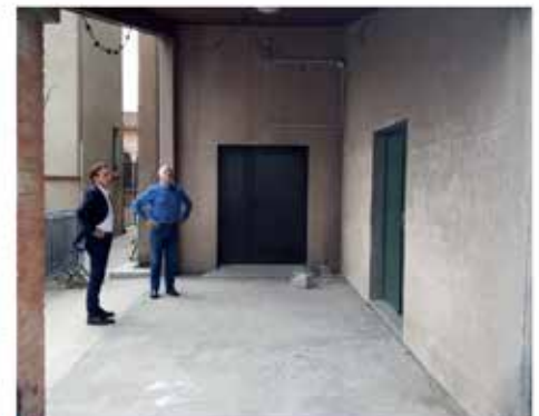
construction prochaine d'un espace rangement et office à la salle polyvalente
