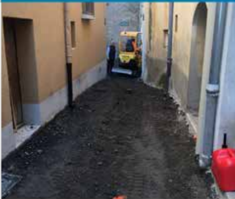
revêtement définitif des voiries du centre ancien
