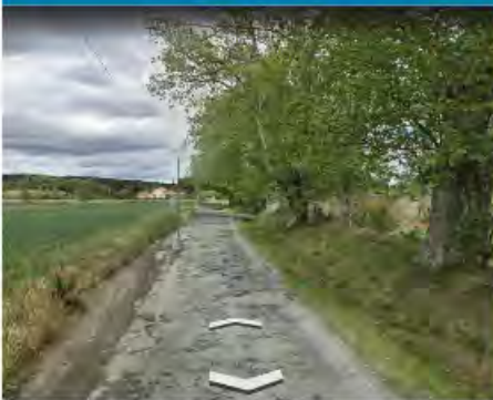
Réfection chemin du Mas Chambon
