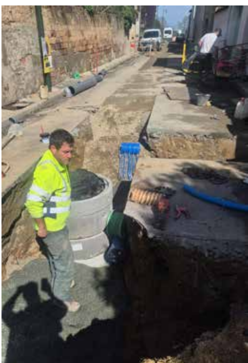
Travaux rue de la Tranquillité
